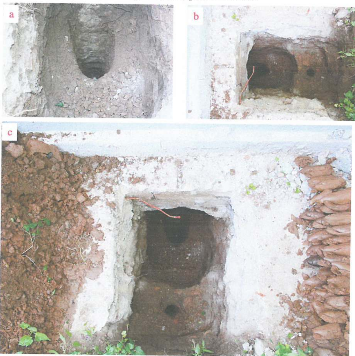
Foto 3 – Sondajul descopertă ( a – frontal, b – de sus, c – de ansamblu)
